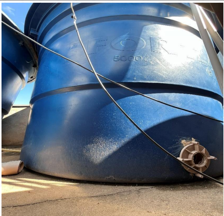
Foto 104: Caixa d'água danificada
